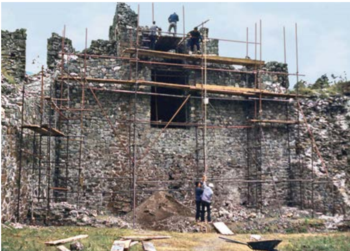
Sl. 26. Južni bedem sa kulama IV–VI, u toku obnove 1978. g.
