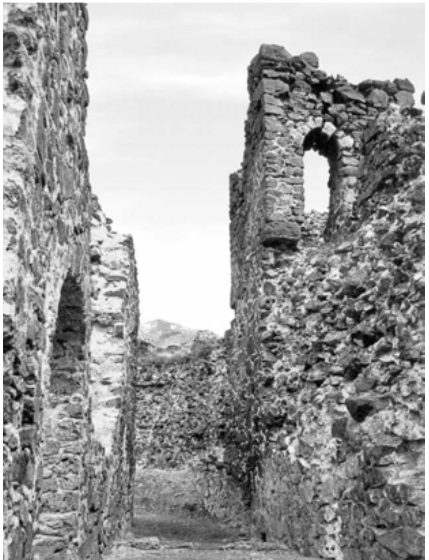
Sl. 14. Kula II, stanje pre obnove
