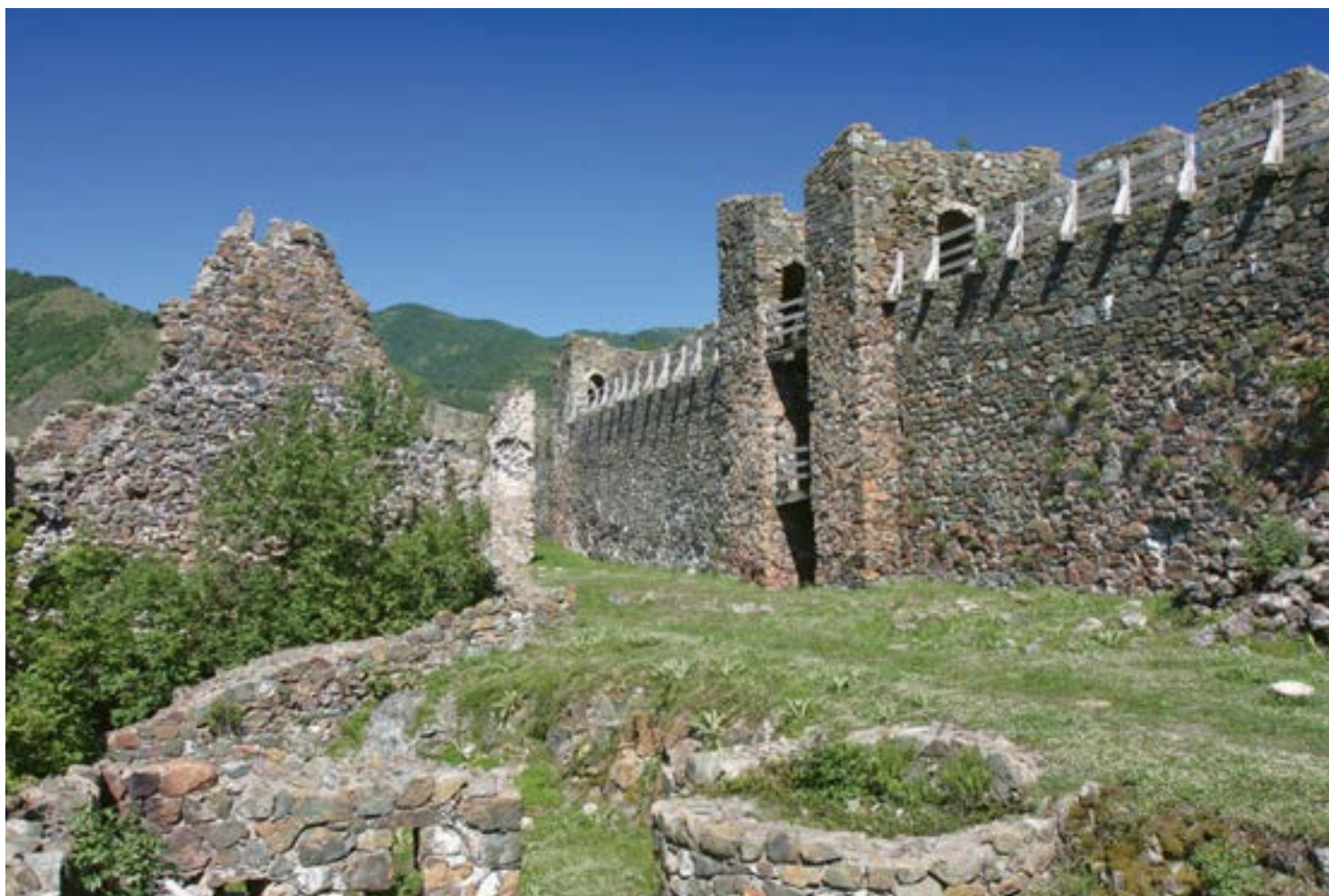
Sl. 48. Jugoistočni bedem sa kulom III, stanje posle obnove (foto iz 2006. g.)
