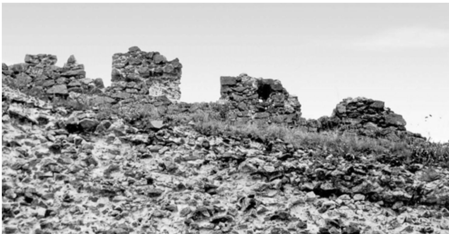
Sl. 13. Ostaci zubaca na Jugoistočnom bedemu, stanje pre obnove
