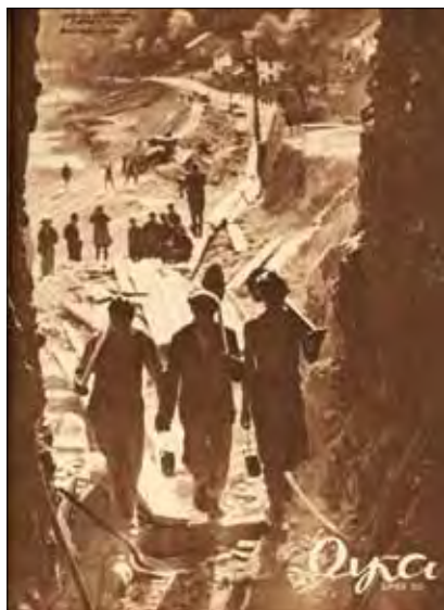
Сл. 5 – Изградња тунела Врандук, Дуга , бр. 90, Београд 1947.
