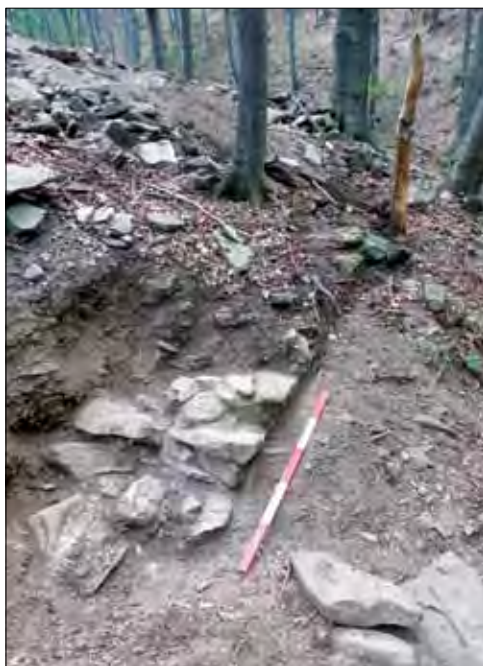
Сл. 11 – Потпорни зид Fig. 11 – Supporting wall
